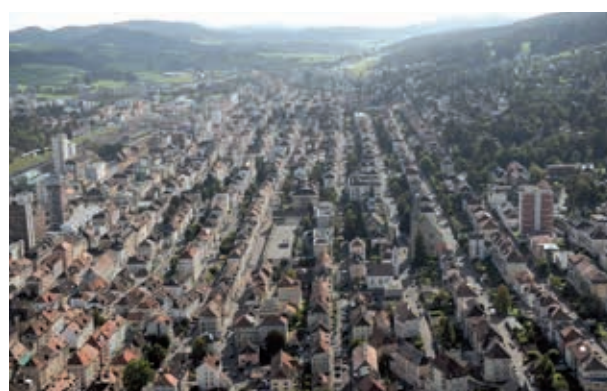
Abb. 67 La Chaux-de-Fonds: urbane Stadträume am Hang
