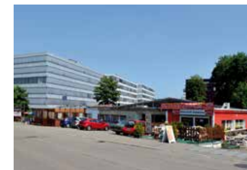
Adaptierte Restflächen: Die baurechtlich nicht als Gebäude geltenden Barracken des «Food-Courts» im Cher bei Glattbrugg sind Resultat lokaler Verpflegungsnachfrage und einer planerischen Gesetzeslücke.
