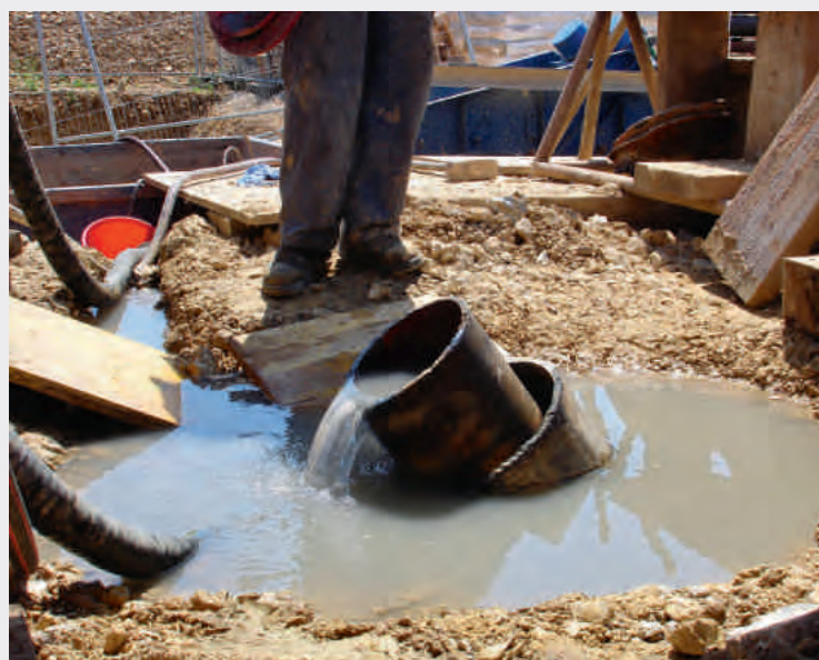
Fig. 2 Le forage profond de Miécourt dans le canton du Jura, une alternative d'exploitation des eaux souterraines en milieu karstique
