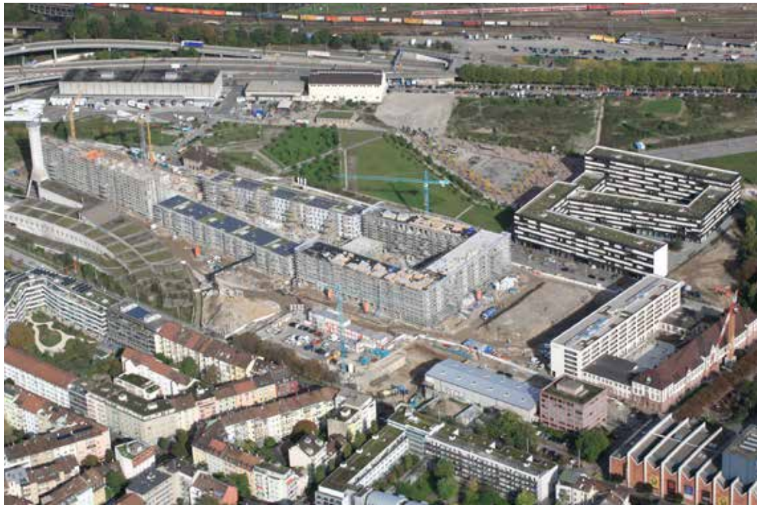
Erlenmatt, vue d'ensemble de la situation en 2014
