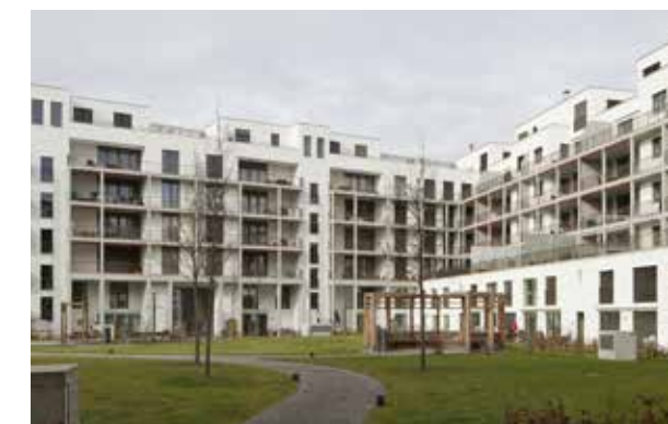
Vue de l'intérieur de la cour des immeubles
